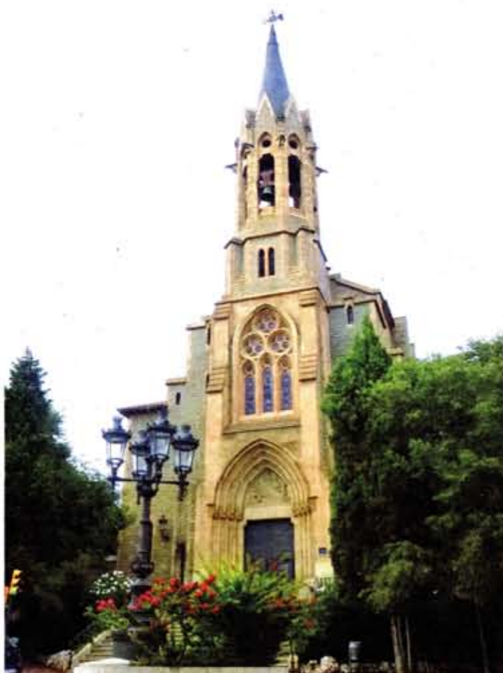
Fachada principal de la iglesia.
